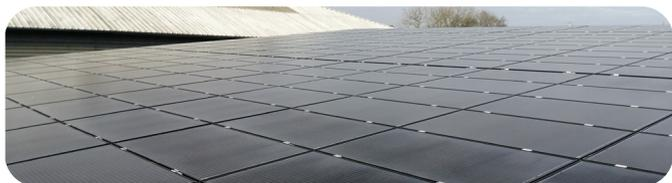
Deux centrales photovoltaïques ont été installées et mises en service. Une première sur le toit de l'école et une seconde sur le toit du préau de la commune de Plourin. Les deux installations ont une puissance cumulée de 87 kWc. Leur production annuelle représente le double de la consommation de l'école.
